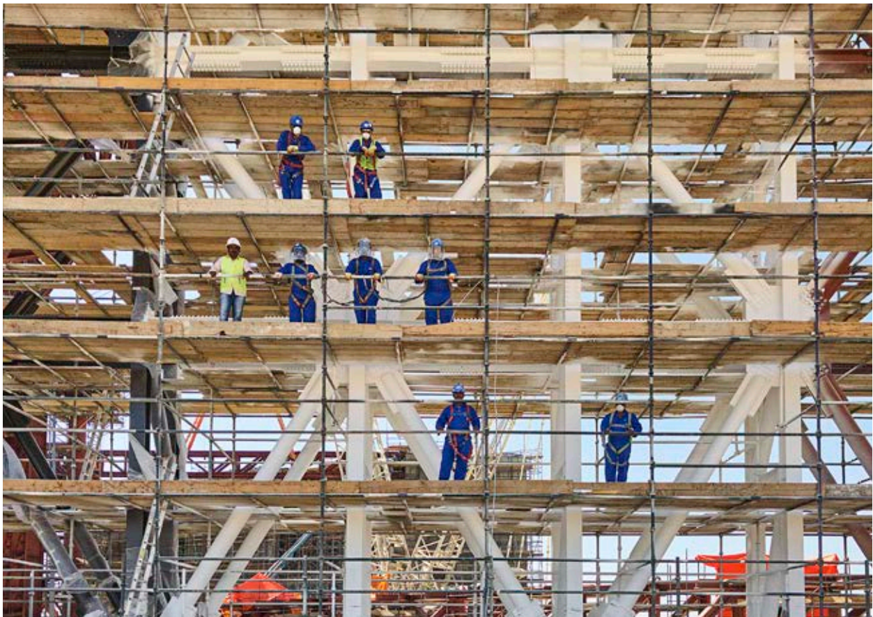
Brandschutzarbeiten am Across Ages Museum, Nizwa, Oman
