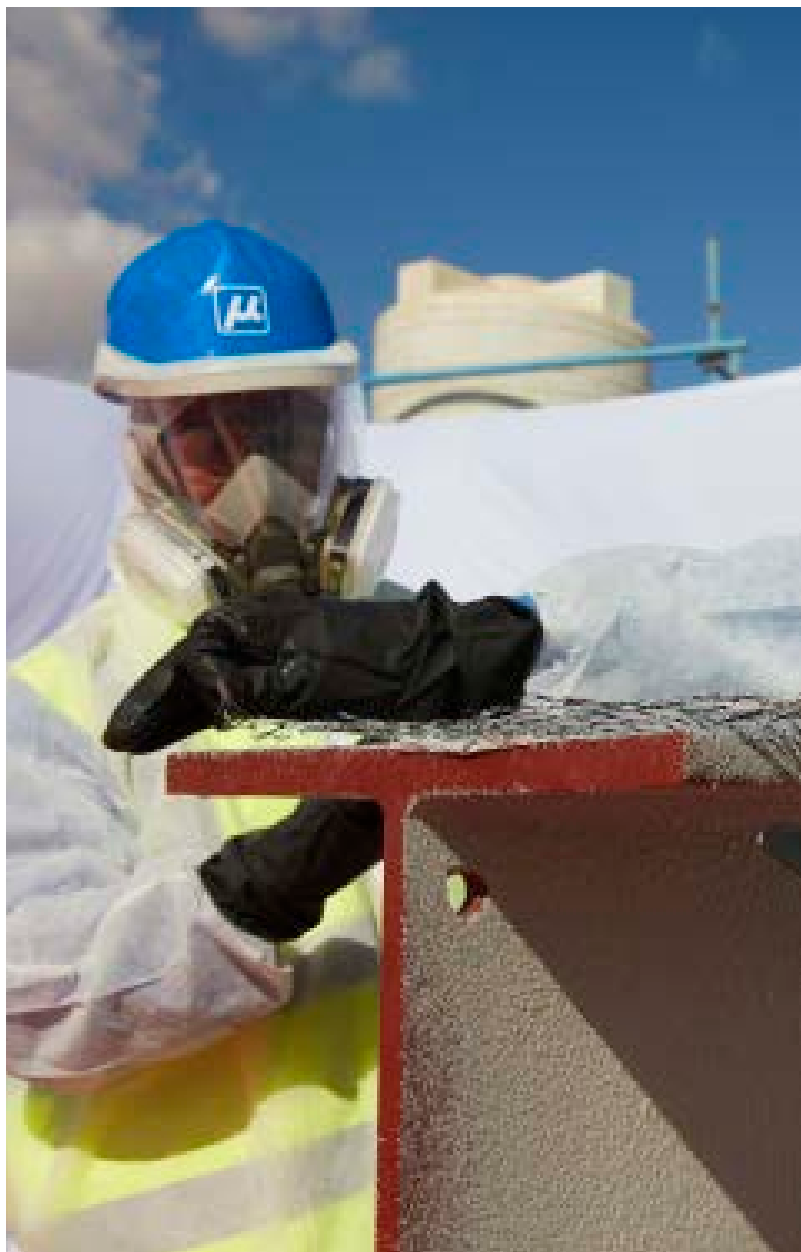
Aufbringen von passivem Brandschutz
