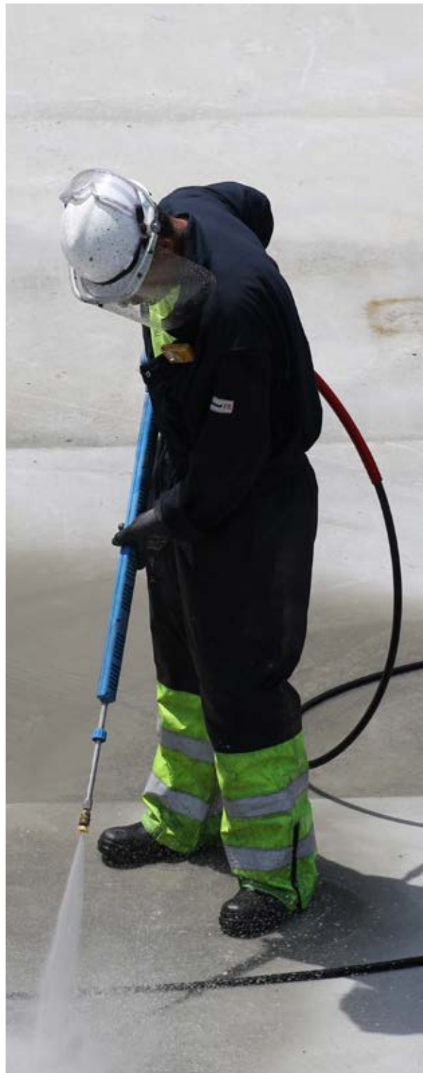
Vorbereitung von Korrosionsschutzarbeiten
