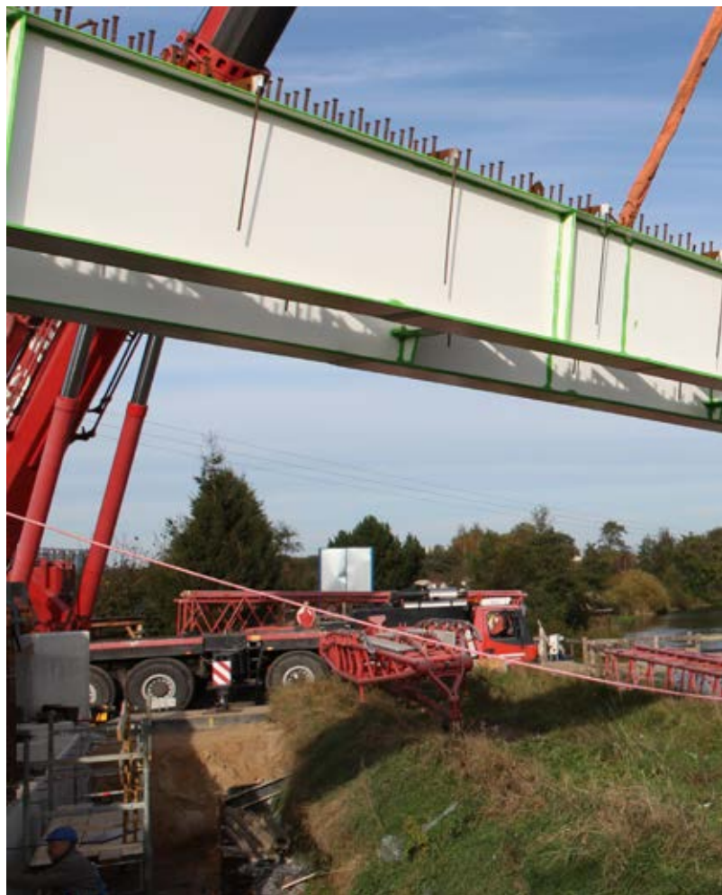
Bau einer Stahlbrücke
