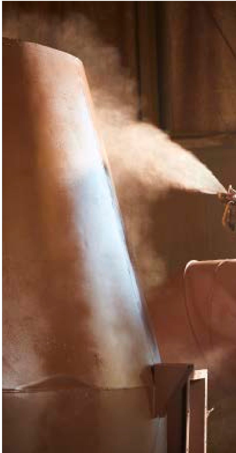
Aufbringen von Korrosionsschutz
