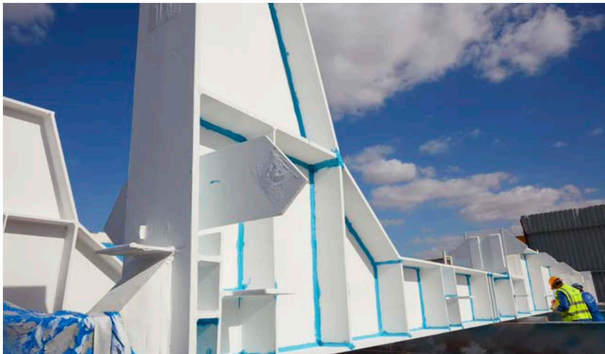
Aufbringen von passivem Brandschutz
