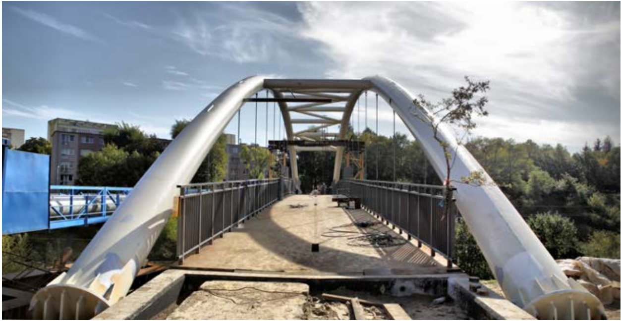
Bau einer Stahlbrücke
