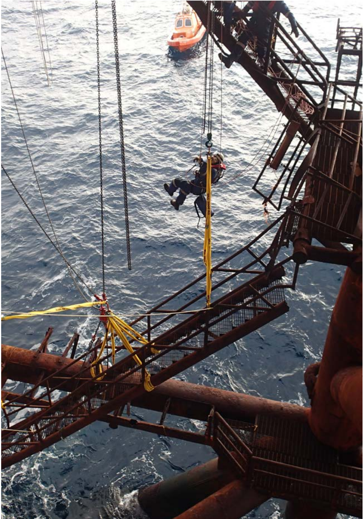
Zugangstechnik auf einer Ölplattform
