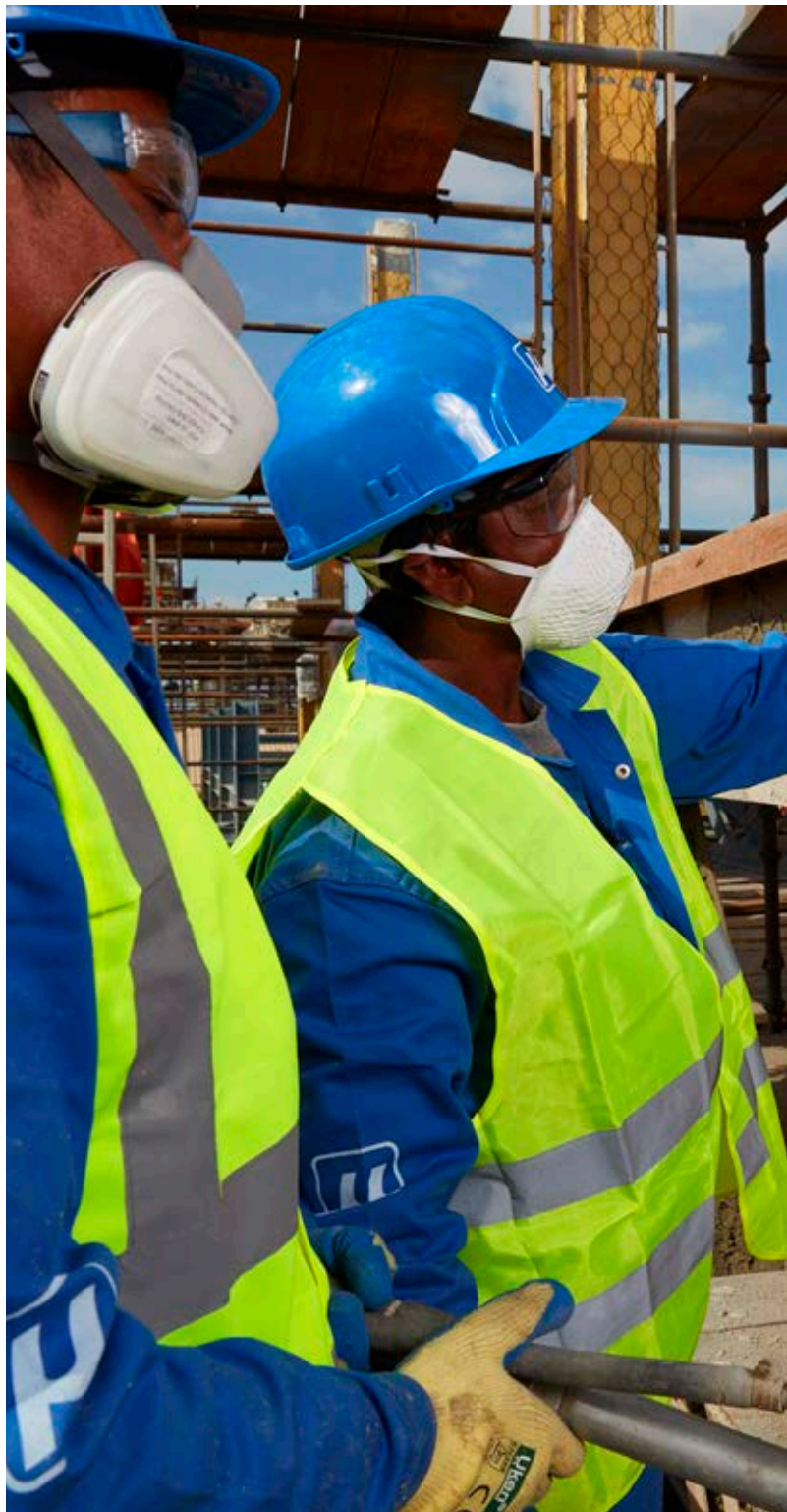
Aufbringen von passivem Brandschutz
