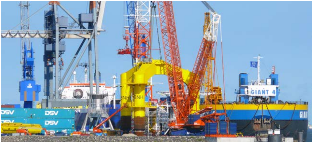
Verladung von Tripods für einen Offshore-Windpark in Hooksiel
