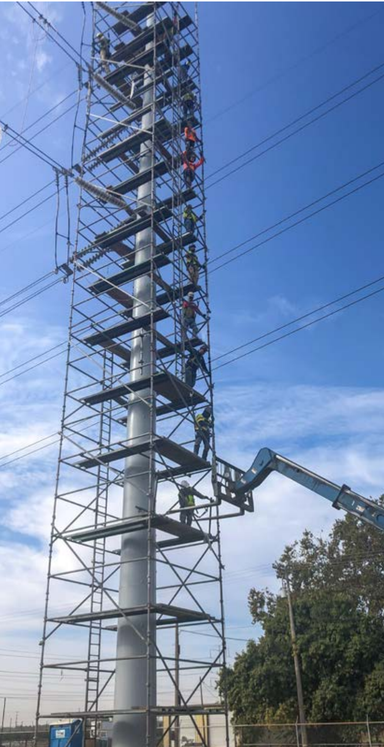
Zugangstechnik und Gerüstbau
