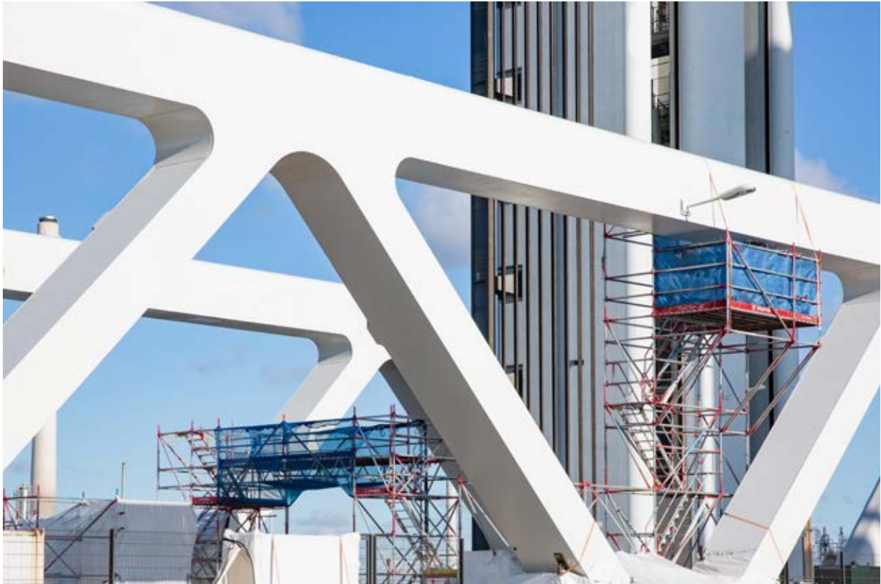
Aufbringen von Oberflächenschutz
