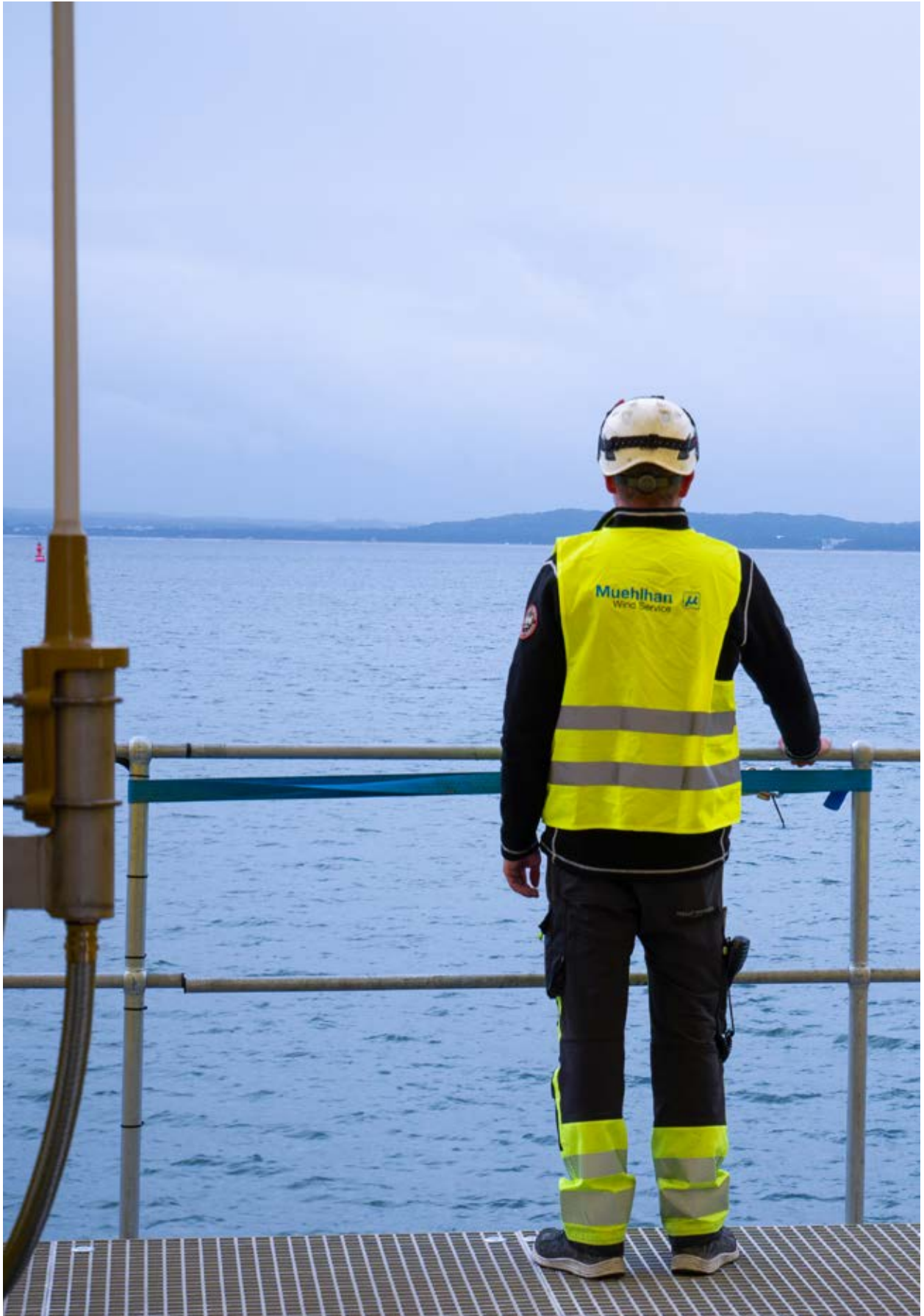
Service-Arbeiten auf einer Offshore-Windkraftanlage
