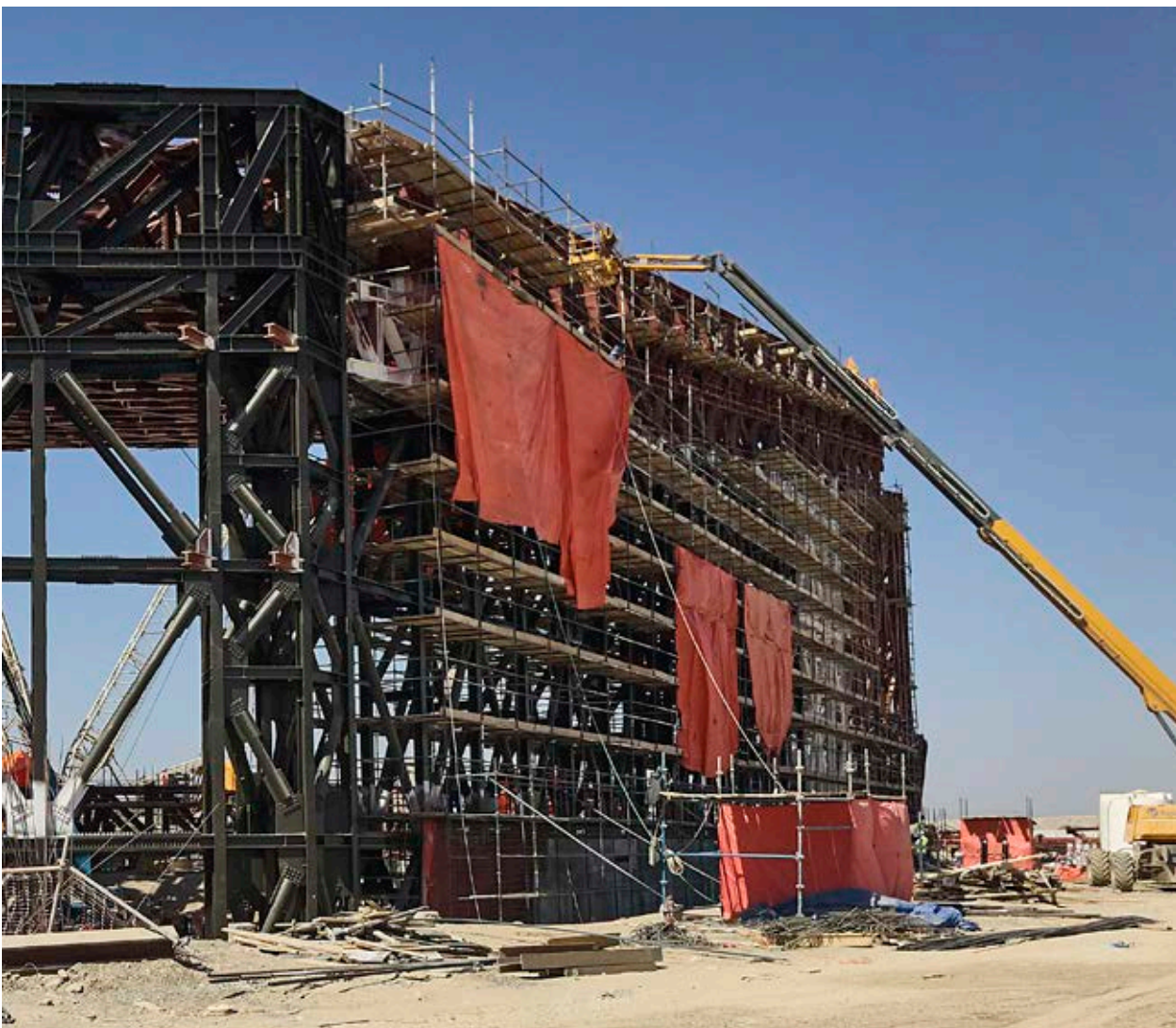
Brandschutzarbeiten am Across Ages Museum, Nizwa, Oman
